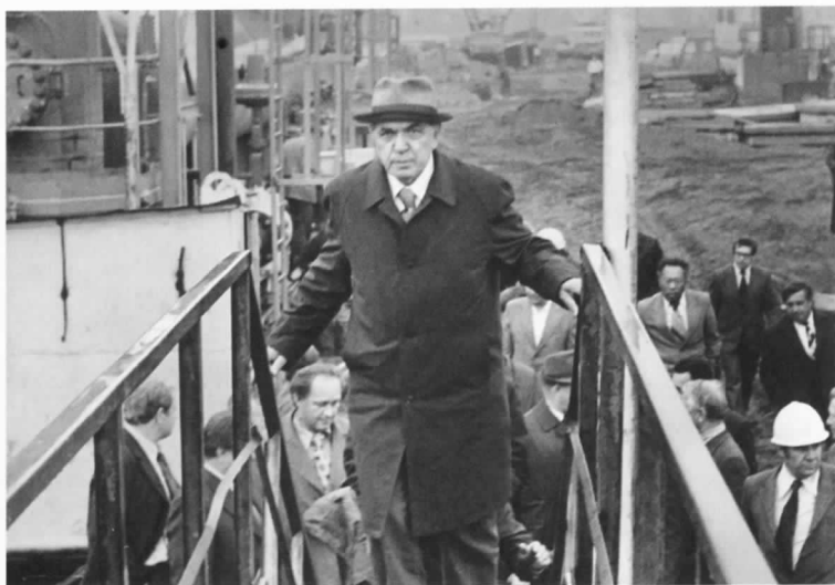
На строящемся промышленном объекте. 1970-е гг.
