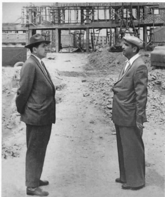
На строительстве нового завода в Баку. 1950-е гг.
