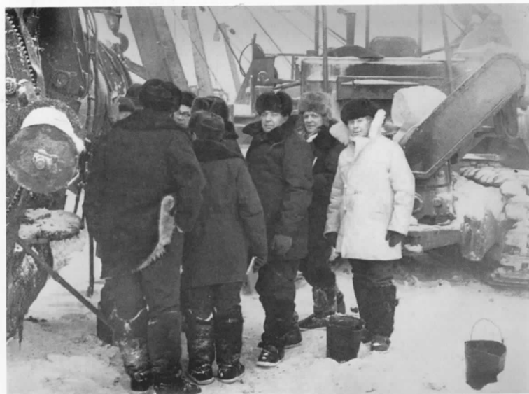
На трассе строящегося газопровода
